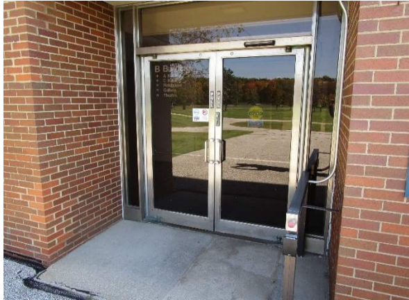
Exterior Door B156A
