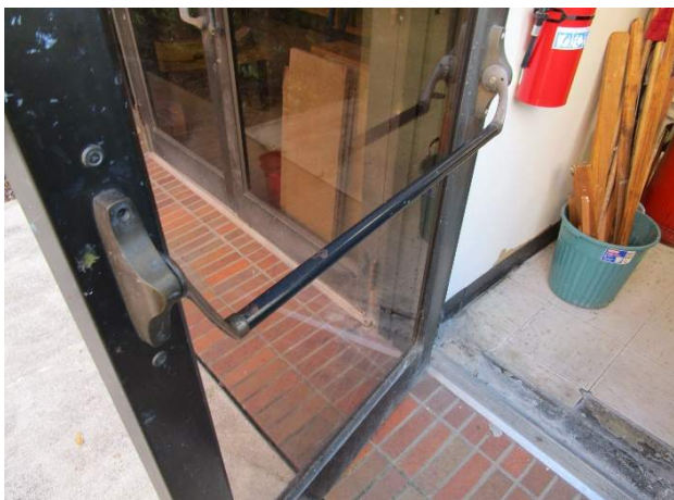
Exterior Door A135
