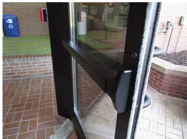
Exterior Door B155
