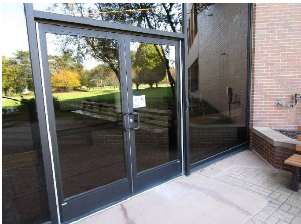
Exterior Door B155
