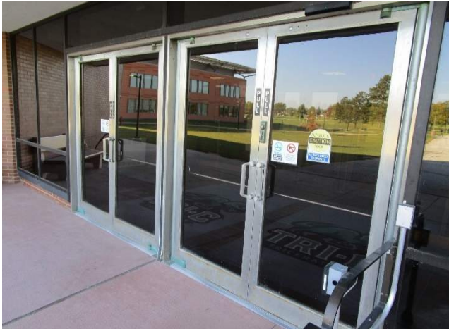
Exterior Vestibule Doors E108
