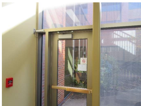
Exterior Stairwell Door HTC100
