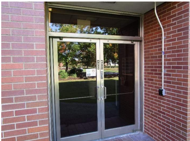
Exterior Door B152
