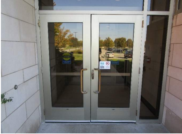
Exterior Door C103
